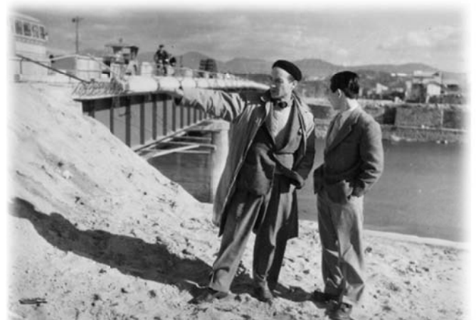
平和大橋の建設現場を視察するイサム・ノグチさん(左)と丹下健三さん(1951年11月26日)
